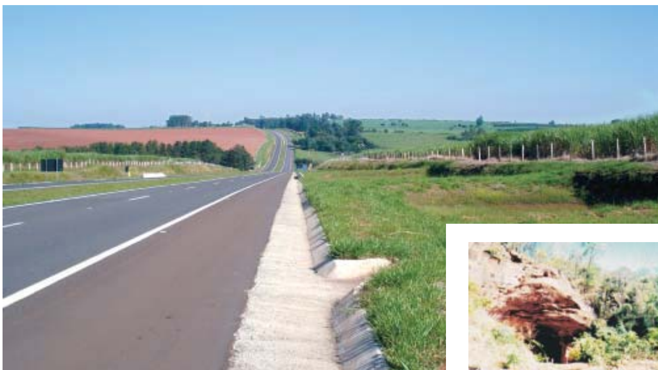
Figura 14.54 – Obra viária bem executada em uma área de solos arenosos, dotada de obras de disciplinamento das águas das chuvas e de bacias de contenção em suas margens (trecho de rodovia que liga a cidade de Brotas à cidade de Jaú, SP).
