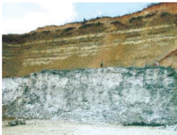
Figura 14.46 – Talude de corte com exposição de rochas calcárias na base e sedimentos siltico-argilosos no topo, dois materiais de características geomecânicas e hidráulicas bem distintas. A existência de rochas calcárias indica que em um determinado momento as bacias sedimentares passaram por um ambiente marinho.
