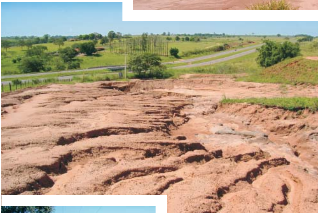
Figuras 14.50 e 14.51 – Processos erosivos induzidos pela concentração das águas das chuvas em um talude de corte e em uma área de terraplenagem sobre terrenos arenosos da Formação Marília (SP). Nos terrenos arenosos, deve-se evitar a execução de obras que envolvem escavações e terraplenagem durante os períodos chuvosos. Obras desse tipo devem ser de imediato dotadas de disciplinamento das águas das chuvas e de proteção contra a erosão.
