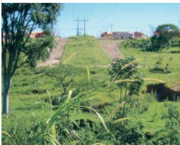
Figura 14.52 – Processos erosivos induzidos pela concentração das águas das chuvas por arruamentos quadriculados e feitos em concordância com o declive do terreno arenoso. Para evitar esse problema, o desenho dos loteamentos em áreas arenosas deve fugir dos modelos quadriculados, de modo a evitar a execução de cortes profundos e a concentração da energia das águas das chuvas, ou seja, devem ser concordantes e não perpendiculares às curvas de nível.
