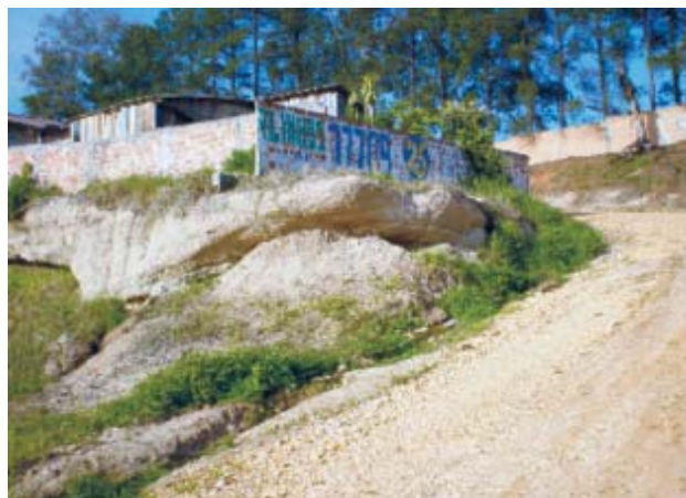
Figura 14.27 – Particularidade geotécnica interessante associada aos sedimentos da Bacia de Curitiba: a base do talude, embora sustentada por sedimentos argilosos, por conter argilominerais expansivos, é bem mais erosiva que a parte superior, sustentada por sedimentos arenosos (região metropolitana de Curitiba, PR).
