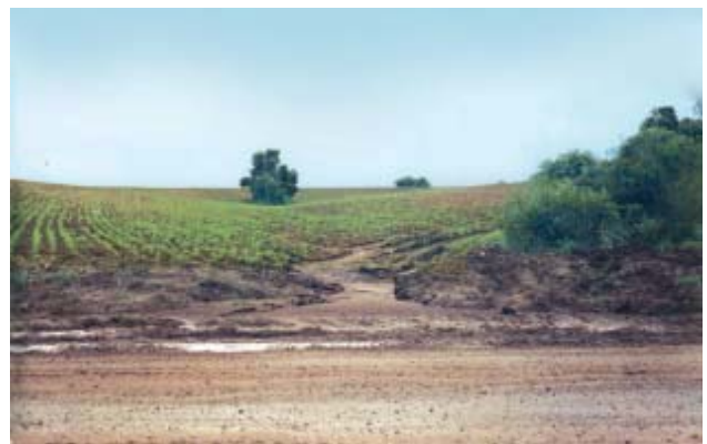
Figura 14.189 – Cicatrizes de erosão induzidas pelo uso contínuo de maquinários pesados sobre solos argilosos residuais de migmatitos (região metropolitana de Curitiba, PR).
