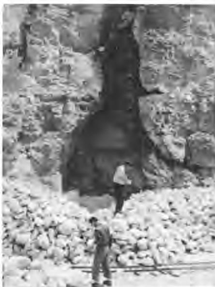
Fig. 33A — "Aven" em forma de funil produzido pela circulação da água ao longo de diáclases em terrenos calcários. Verifica-se algumas vezes, a existência de grandes salões na base do "aven". O alargamento crescente e produzido pelo trabalho de dissolução realizado pelo ácido carbônico sobre o carbonato de cálcio. Esta foto foi tirada numa pedreira na região da Charente Marítima (França) ora em exploração, o que permitiu a possibilidade de se fazer um corte vertical.
